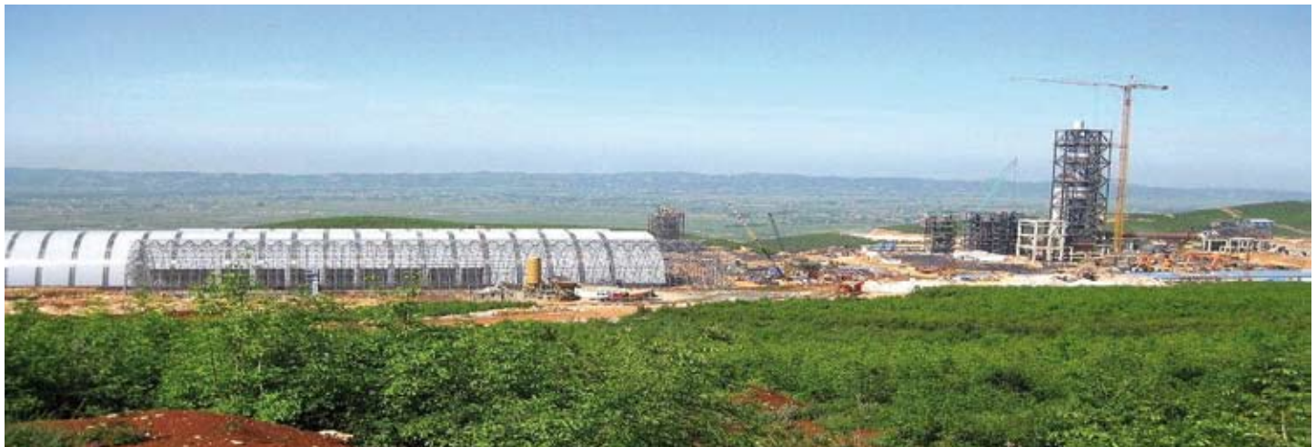
Ανέγερση νέου εργοστασίου τιμέντου στην περιοχή Boka e Kuqe, Αλβανία
