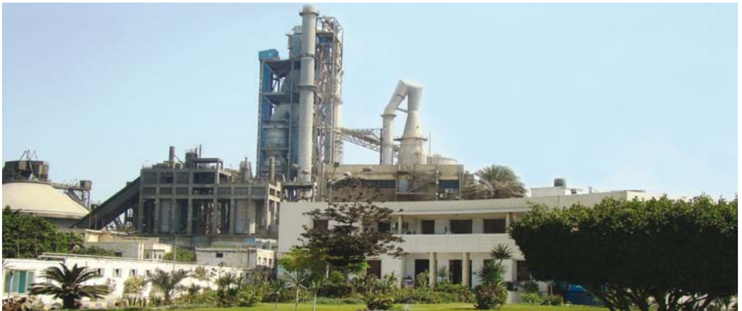
Εργοστάσιο Αλεξάνδρειας, Αίγυπτος
